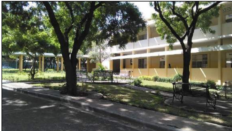
Foto 2.6.6.9-2. Vista del Edificio del liceo Francisco Gregorio Billini, en el municipio de Baní.
