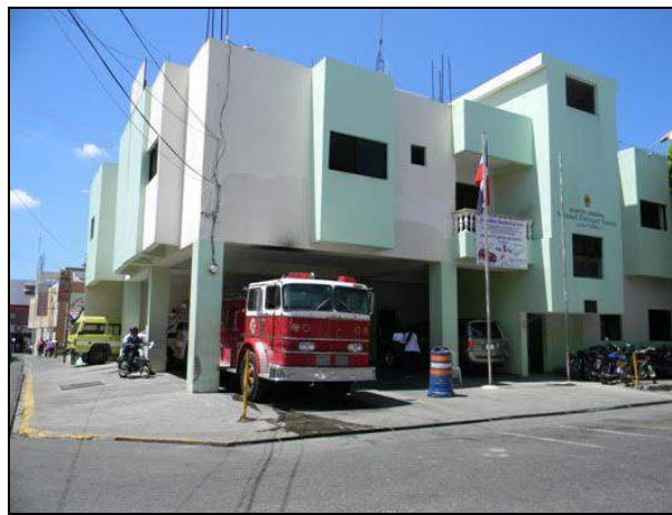
Foto 2.6.6.7-2. Edificio del Cuerpo de Bomberos del municipio de Baní.
