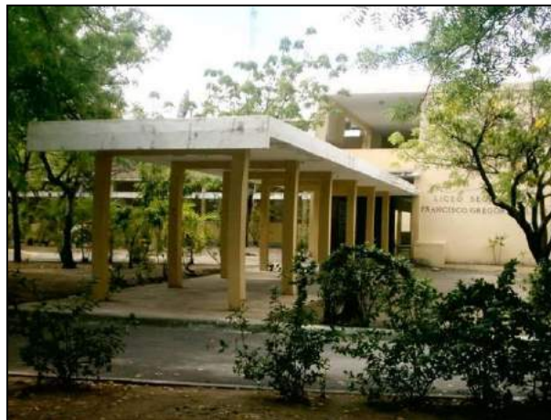
Foto 2.6.6.9-1. Vista del Edificio del liceo Francisco Gregorio Billini, en el municipio de Baní.
