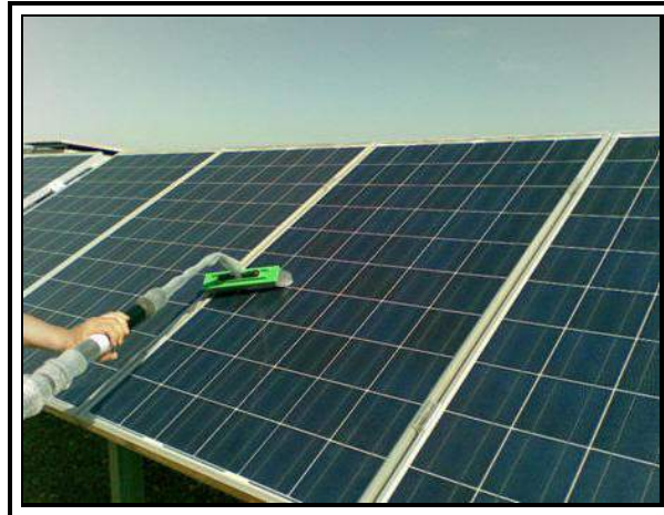
Foto 6.3.3-1. Forma de limpieza de los paneles solares.
